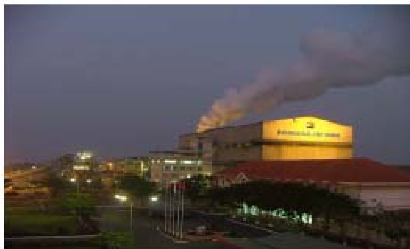
Hình 14: Toàn cảnh Nhà máy của SBT
